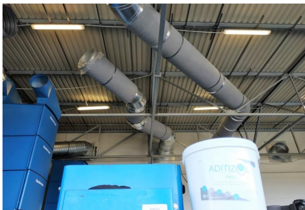
Rurociągi i przewody technologiczne - ciągła warstwa ochronna.
