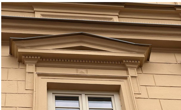
Detal elewacji - cienka warstwa pozwala zachować charakter architektury.
