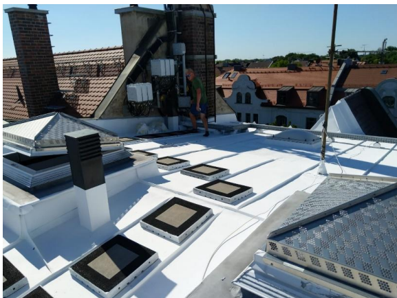
Dach pokryty jasną, ciągłą powłoką termoizolacyjną.
