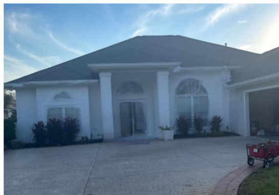
Dom jednorodzinny - gotowa elewacja
