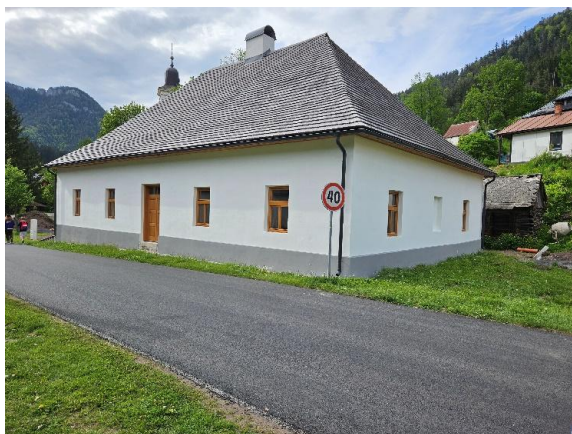
Budynek po modernizacji z wykorzystaniem technologii ADITIZOL.
