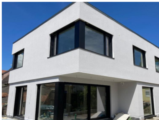
Dom jednorodzinny - realizacja ADITIZOL
