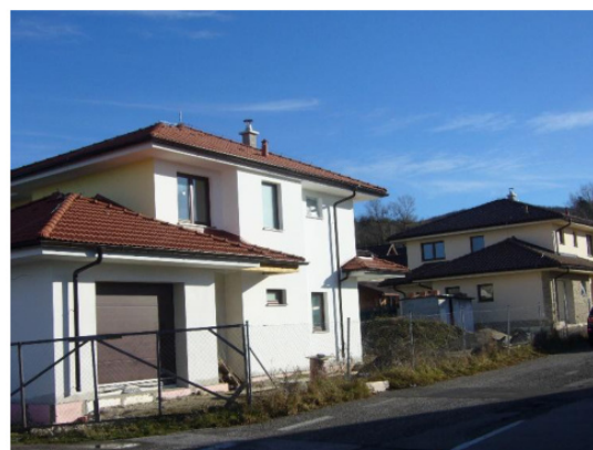
Dom mieszkalny - realizacja elewacji
