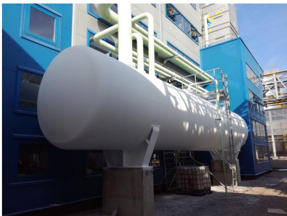
Zbiornik przemysłowy zabezpieczony powłoką ADITIZOL BASIC.
